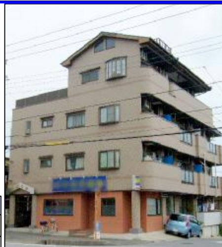
タイル貼りにリニューアルしました ベランダ面は道路です。
